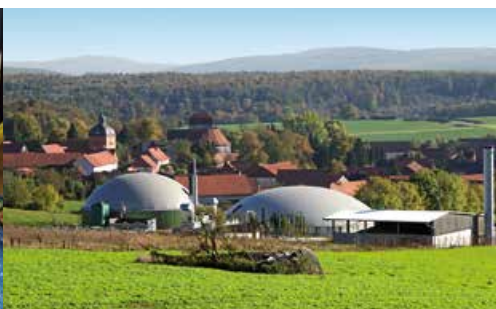
BIOENERGIEDORF JÜHNDE EG FOTO: BIOENERGIEDORF JÜHNDE EG
